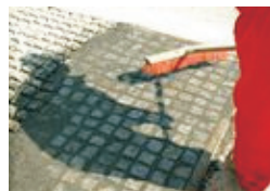
Abschließend sorgfältig Mörtelreste abkehren
