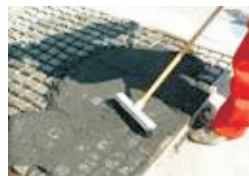
Diagonal zum Fugenverlauf einkehren
