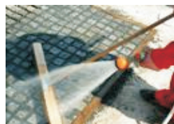
Abschließende Reinigung ggfs. mit weichem Wasserstrahl unterstützen
