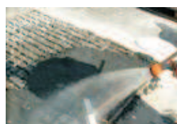
5. Obtenez un meilleur remplissage en arrosant la surface en même temps avec un peu d'eau.
