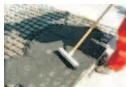
4. Balayez le mortier dans les joints
