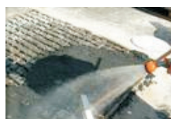
5. Obtienen una mejor compactación al mular la superficie en el mismo tiempo con una ligera agua de niebla
