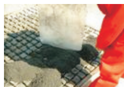
3. Repartan el mortero
