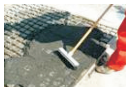
4. Barran el mortero dentro de las juntas
