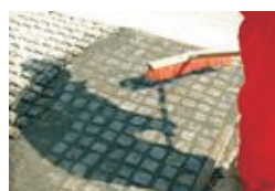
6. Eliminen el mortero restante con ayuda de una escoba suave
