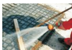
7. Limpien la superficie moderadamente con un chorro del agua
